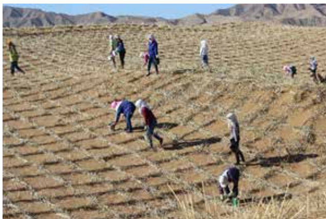
图 18 宁夏中卫构建防风固沙体系（草方格）
