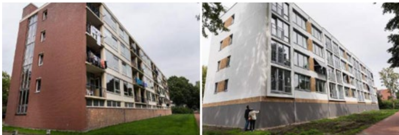
图 1：荷兰 PPP 项目改造前（左）和改造后（右）对比图
