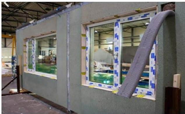
图 10：C 公司外墙板中的集成管道
